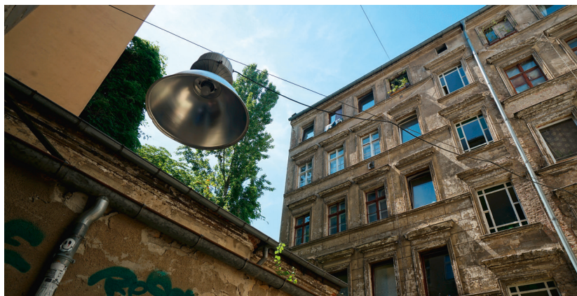
Die Fassaden werden saniert, intakte Fenster sollen erhalten und aufgearbeitet werden.
