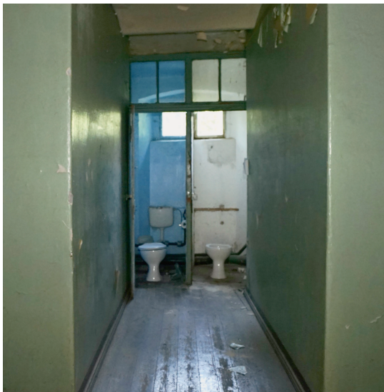
Die Außentoiletten werden ausgebaut. Hier entsteht Raum für einen Aufzug.
