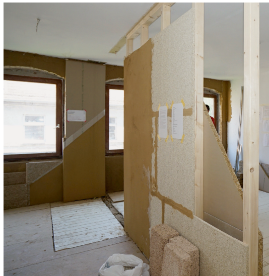
In der Musterwohnung wird der Einsatz von Natur- baustoffen für Trennwände und die Innendämmung der Außenwand getestet.
