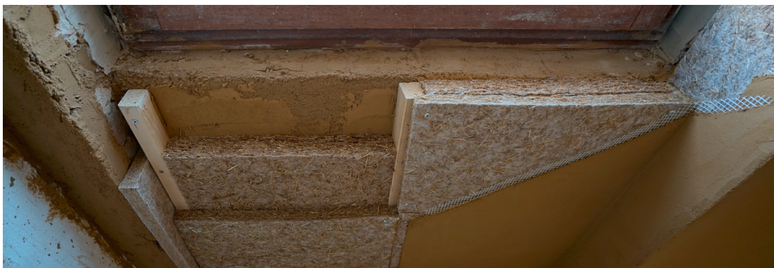
Die Innendämmung muss durch die Deckenkonstruktion hindurchführen.
