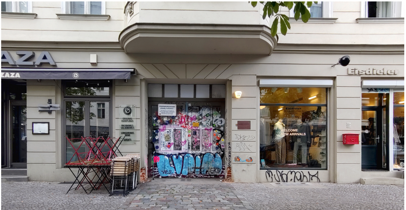
Vorderhaus der K12 mit typischer Gründerzeitfassade. Zu den Treppenaufgängen, Höfen und Quergebäuden führt ein zweiflügeliges graffitibesprühtes Eingangstor.
