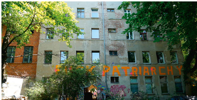
Das dritte Quergebäude, der Prototyp, soll im nächsten Jahr saniert sein. Es ist bereits leergezogen.
