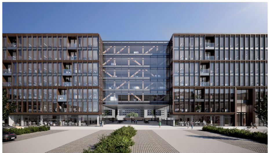
Optimierte Fachwerk-Diagonalen ermöglichen Durchgänge zwischen den einzelnen Bereichen. (Ansicht von der Stralauer Allee)
